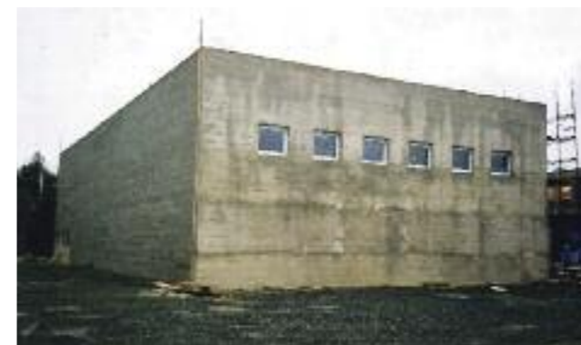
Slik så lagerbygningen ut før man tok ut hull i murveggene til butikk- og kontorvinduer. (Privat bilde).
