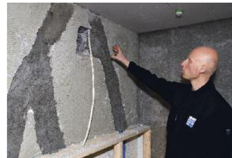
– I gammel mur og ny puss hugges det ut til elektriske føringer, forklarer Thommesen.
