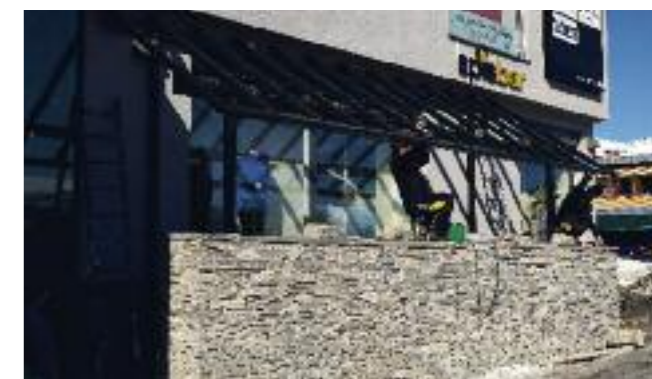
En råkopp-mur i Oppdal sentrum er under oppføring.
