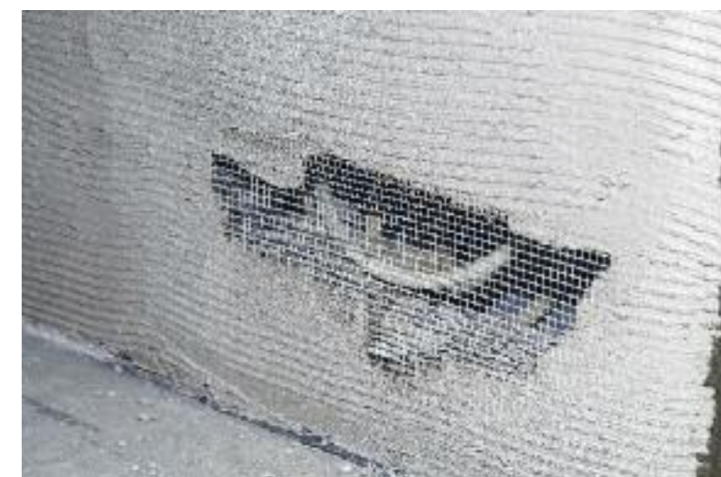
Med maxit Fiberpuss-system unngår man fremtidig sprekker i overflaten. Her skal det tilpasses hull for elektriske føringer.
