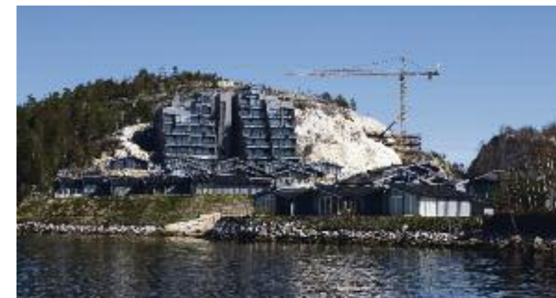
Prosjektet har en utfordrende logistikk fordi prosjektet er på en øy med liten fraktekapasitet. Trinn 3 skal stå ferdig i oktober.
