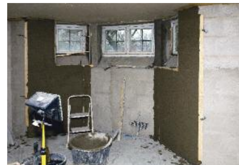
Rehabiliteringen av den eldre kjelleren er i gang, og det er mange detaljer å ta hensyn til.
