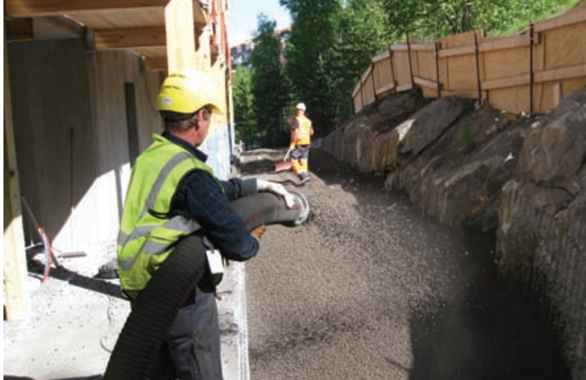
Referanseprosjekt tilbakefylling på Mortensrud, Oslo.
