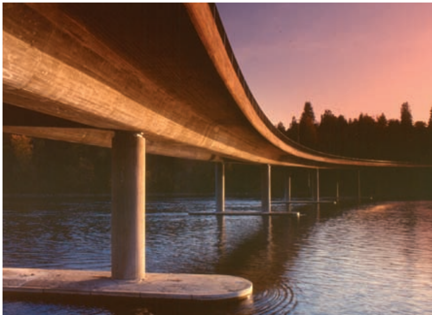
Ny Sundbru, Eidsvoll. Høyfast Leca Lettbetong
