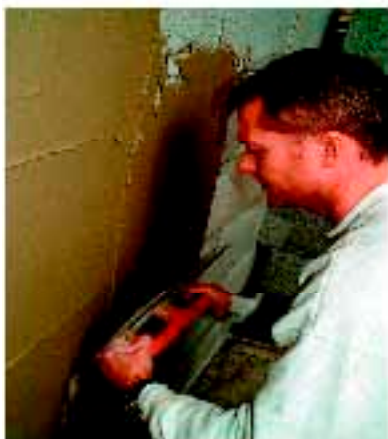
1) 1 sjikt Fiberpuss trekkes på i 4-6 mm.
