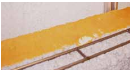
Leca Fugearmering utlagt
