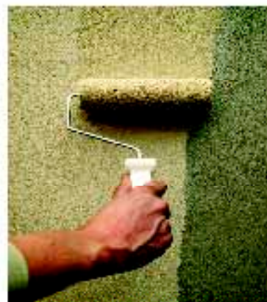
6) Sluttbehandling påføres etter ca 14 dager herding.
