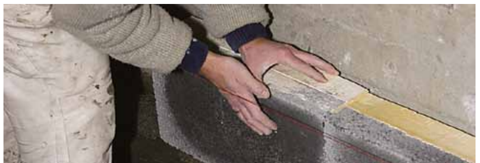
Innvendig bruk av Leca Fasadeblokk er en enkel form for etterisolering.
