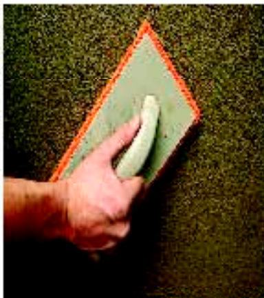
5) Fiberpuss filses evt. kastes eller brettskures.
