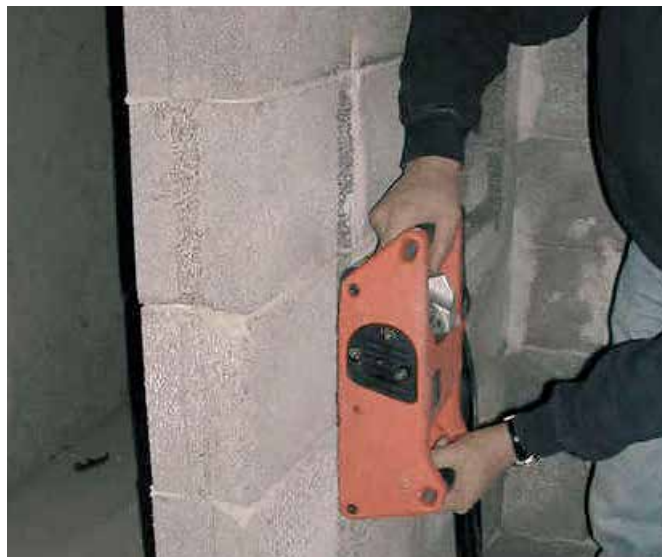
Figur 4.41 Slissing av spor for rør
