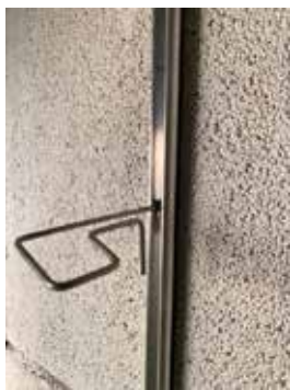
Figur 9.3b Forankring Leca Fasadeblokk
