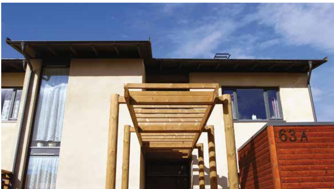
Boliger Tungaplatået, Trondheim, HSØ Arkitektkontor A/S, v/ sivilarkitekt MNAL Jeanett Renlund. Murmester: Geir Skaget
