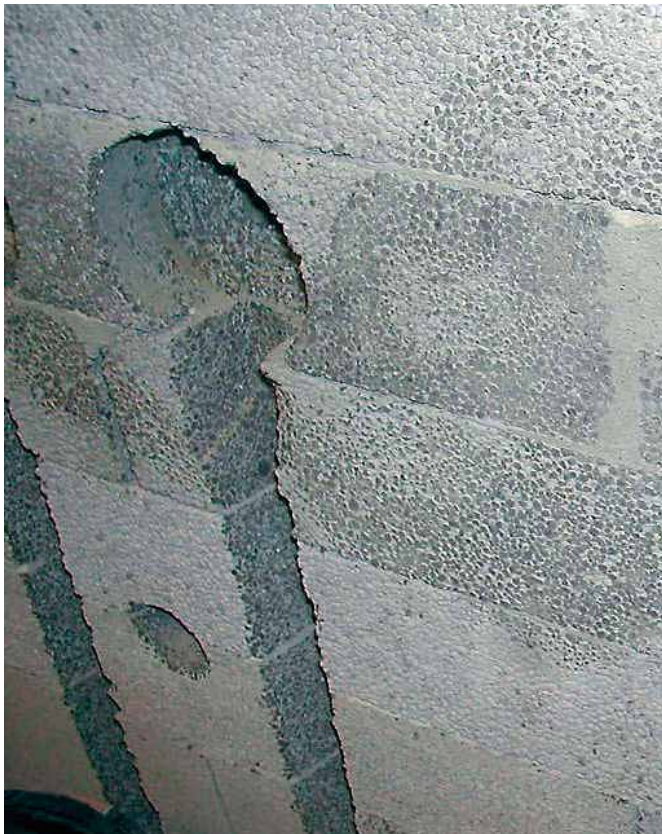
Figur 4.43 Spor til rør i slisset Leca vegg
