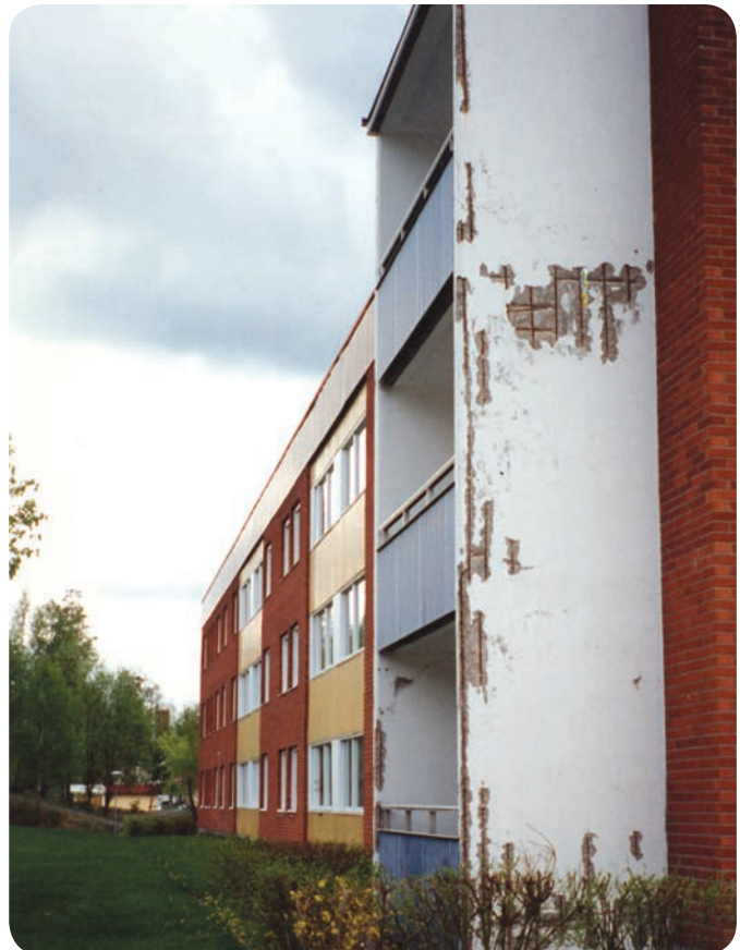
Korrodert armering
