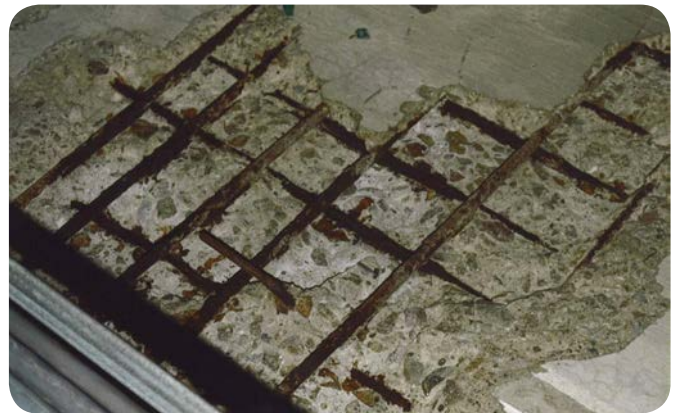
Armeringskorrosjon
